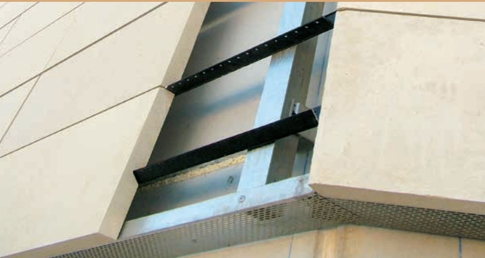
Esempio di lastre squadrate per facciate ventilate. Beispiel der Anbringung rechteckiger Steinplatten für eine hinterlüftete Fassade.
