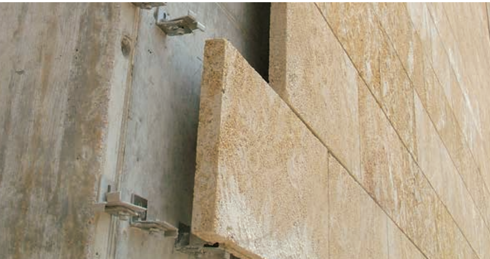
Esempio di lastre squadrate per facciate ventilate. Beispiel der Anbringung rechteckiger Steinplatten für eine hinterlüftete Fassade.
